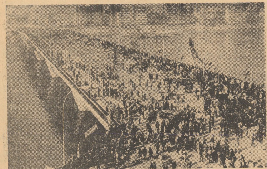
R.A.U. Recent a fost inaugurat un nou pod peste Nil, la Giza oraș situat pe cealaltă parte a Nilului vis-à-vis de Cairo. Podul construit din beton va permite un trafic intens și peste el va trece și o linie de troleibuz. În foto: podul imediat după inaugurare
