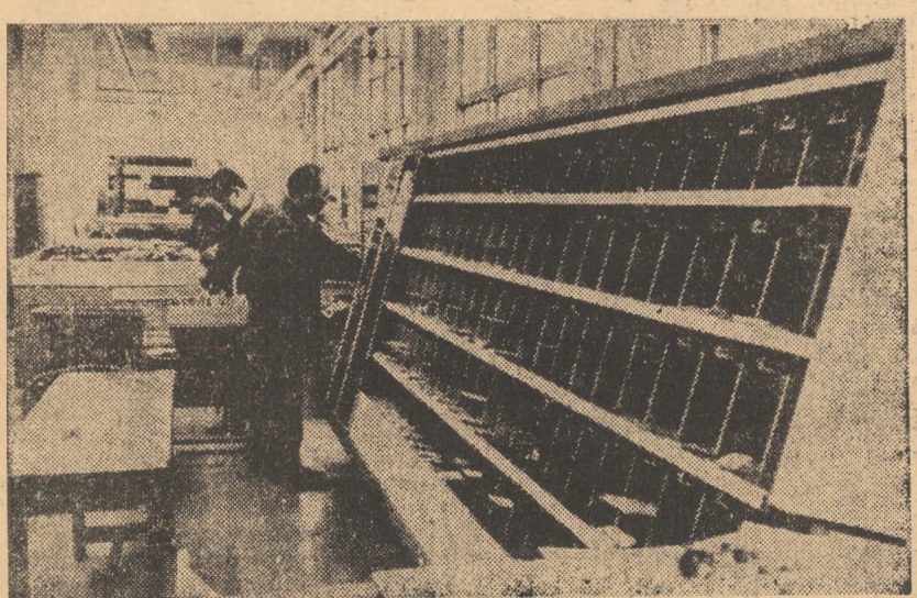
JAPONIA. La serviciile poștale din Japonia volumul expedițiilor a crescut considerabil în ultimii ani. Pentru a ușura munca funcționarilor au fost introduse la oficiile poștale o serie de mașini. În foto: mașină de citire și separare automată a adreselor de la Oficiul poștal central din Tokyo
