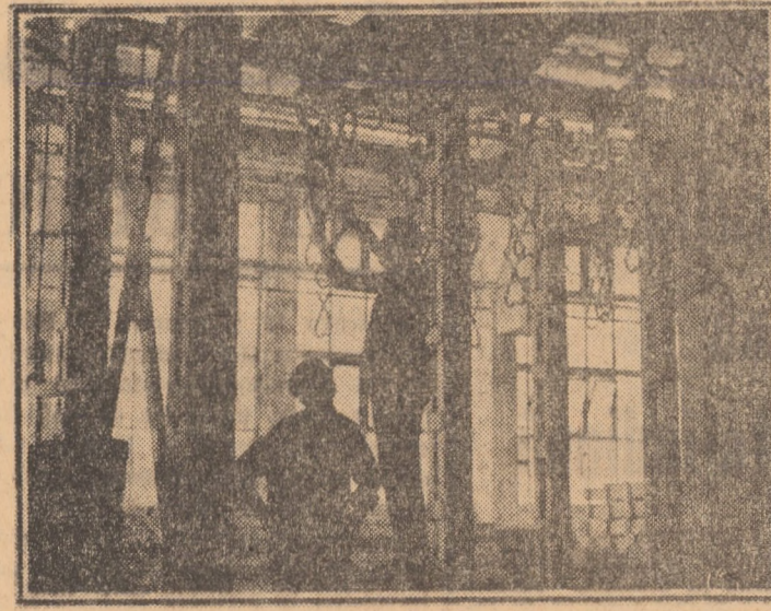
Se pregătește o nouă „premieră” în domeniul autoutilării — instalația de fosfat și vopstre a arcurilor lamelare Foto: FRED NUSS
