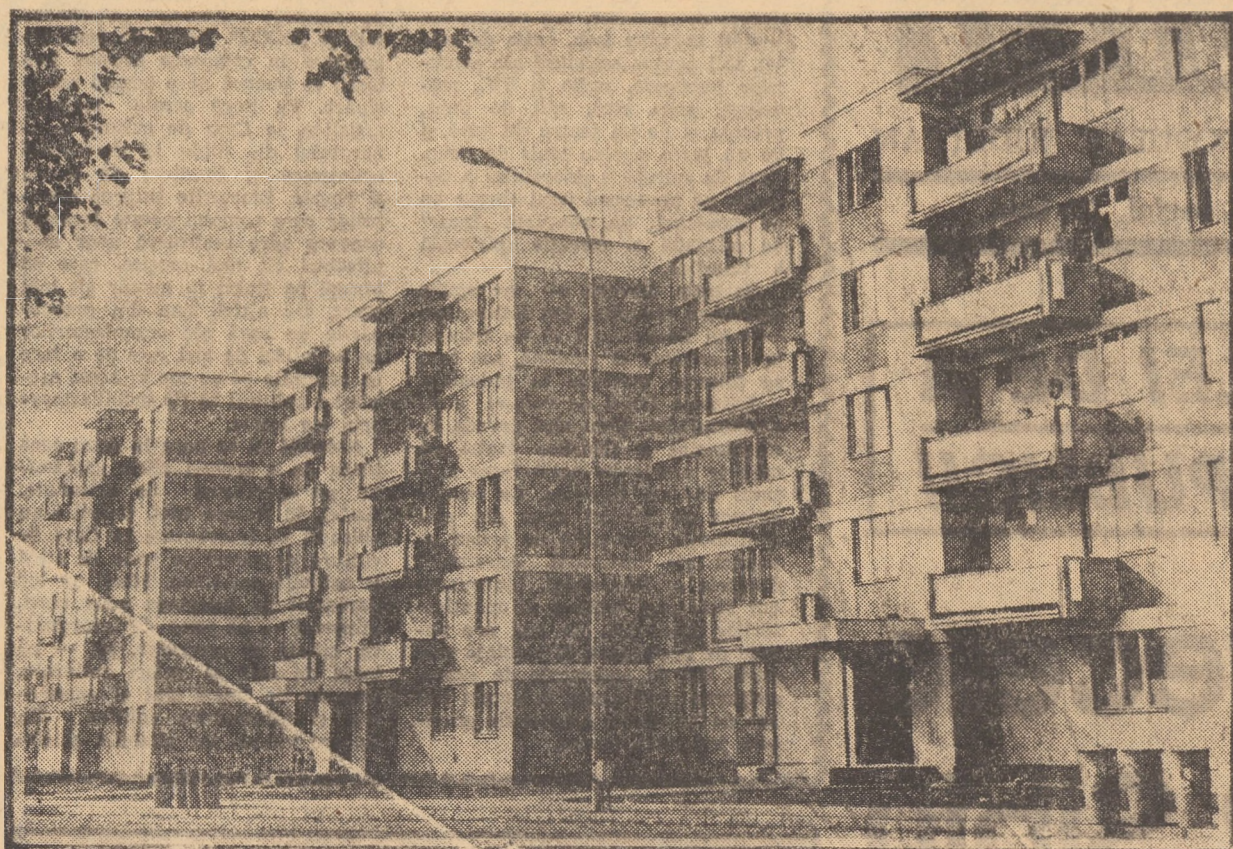
Dintre construcțiile cartierului Hipodrom II, din Sibiu, recent date în folosință
