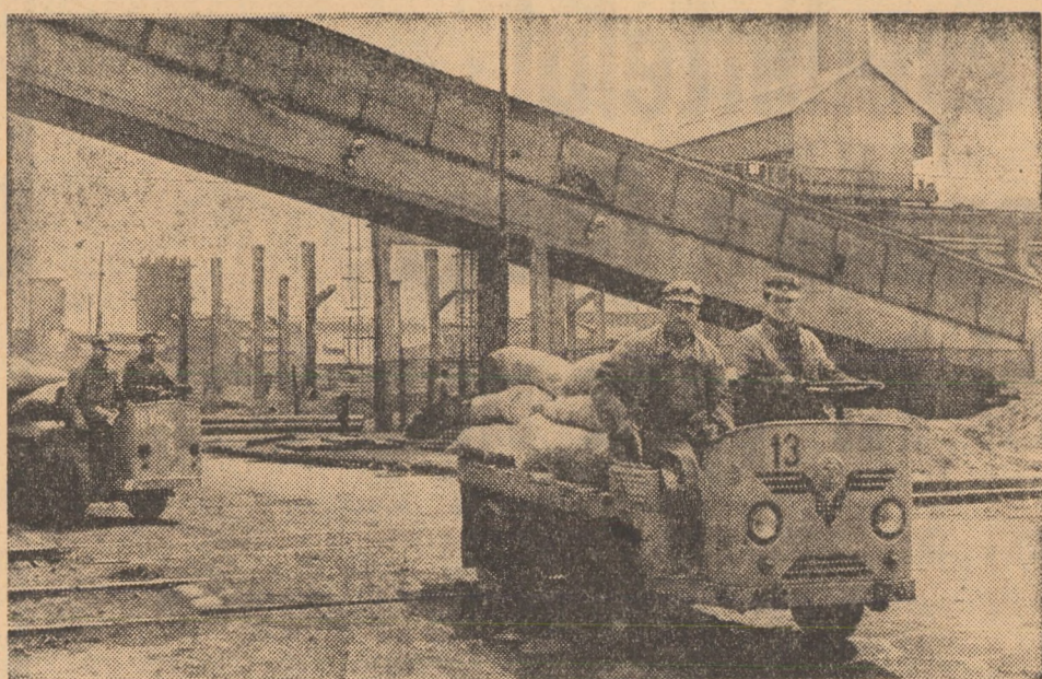
Transportul materialelor auxiliare în incinta I.M.M.N. Copșa Mică
