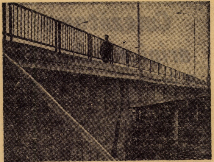
Viaductul peste linia ferată, inlesnind circulația neîntreruptă spre noua zonă industrială a municipiului Sibiu
