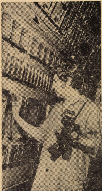
Camera de comandă a instala-ției de granulare umedă a ne-grului de fum. Operatorul Ioan Gligor
