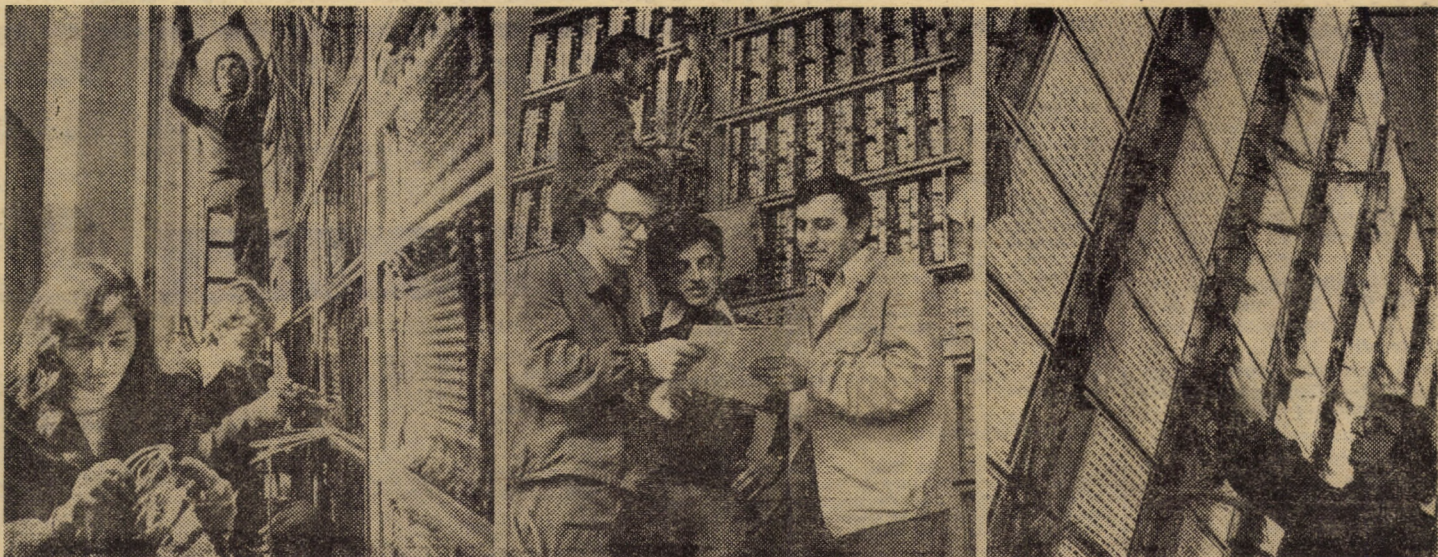
Lucrări de instalare și montare a noii Centrale telefonice automate din cartierul sibian Hipodrom III, cu o capacitate finală de 10 000 posturi
