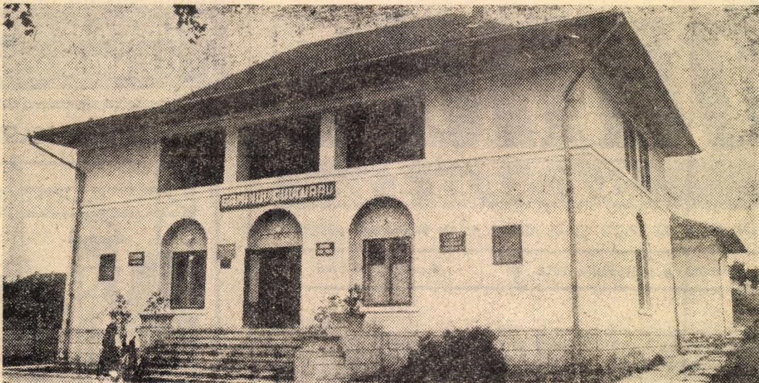
Clădirea Căminului cultural din Orlat nu e numai frumoasă dar și asiduă căutată de localnici. Aici există o bibliotecă cu peste 7000 de volume, un club și bineînțeles o sală de spectacole, unde repetă și se produc formațiile de călușari, de teatru și estradă. Tot aici în micromuzeul comunei, orlătenii adăpostesc facsimile vorbind despre opera și viața scriitorilor ce au creat aici în comună: L. Rebreanu, I. Agârbiceanu, Petrea Dascălu
