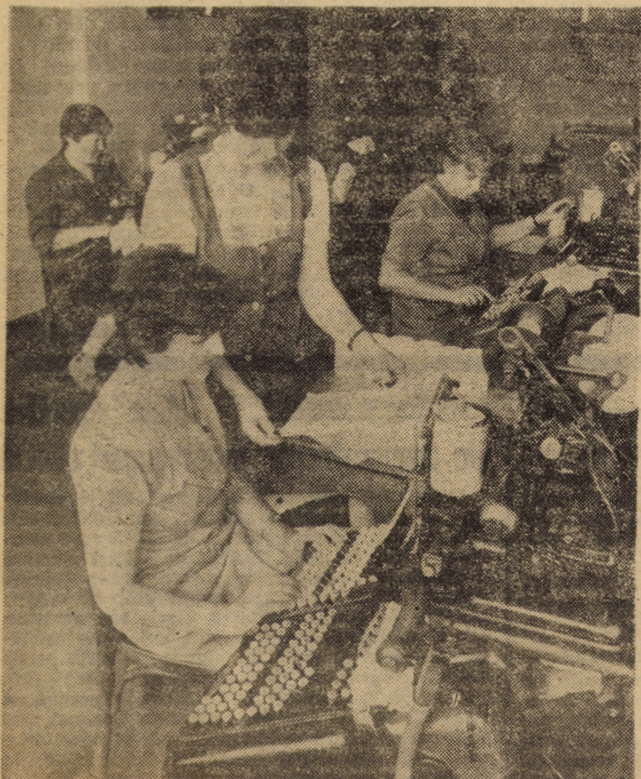
Aspect din sectorul tastere al întreprinderii poligrafice Sibiu, unde se perforează benzi pentru mașinile de turnat litere — monotip Foto: Fred NUSS
