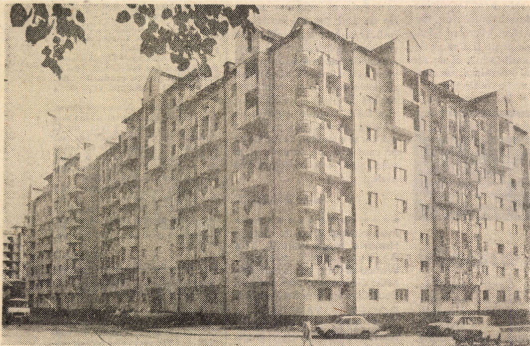
Blocul cu 7 etaje din fotografie, această construcție reușită, cel puțin din punct de vedere al concepției arhitecturale, a fost ridicat pe str. Lungă din Sibiu. Nu aceleași cuvinte de laudă pot fi enunțate, însă, la adresa carosabilului străzii mai sus amintite. Ce se vor face, bieții oameni, când se vor instala ploile de toamnă?
